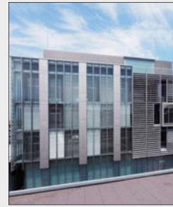
▲ Kanazawa-hakkei campus, Kanto Gakuin University (Kanagawa, Japan)
